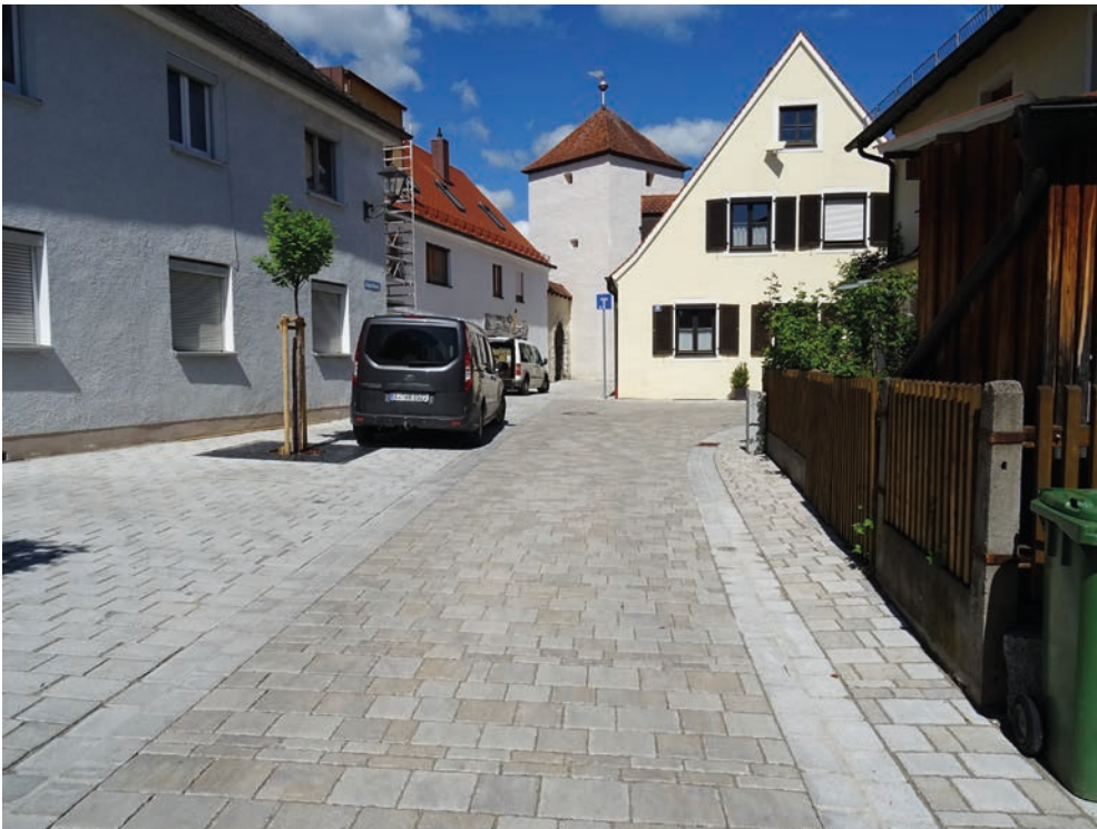
Beilngries, Lange Gasse Belag: Granitpflaster, Betongestaltungspflaster Via Castello, Fa. Egner
