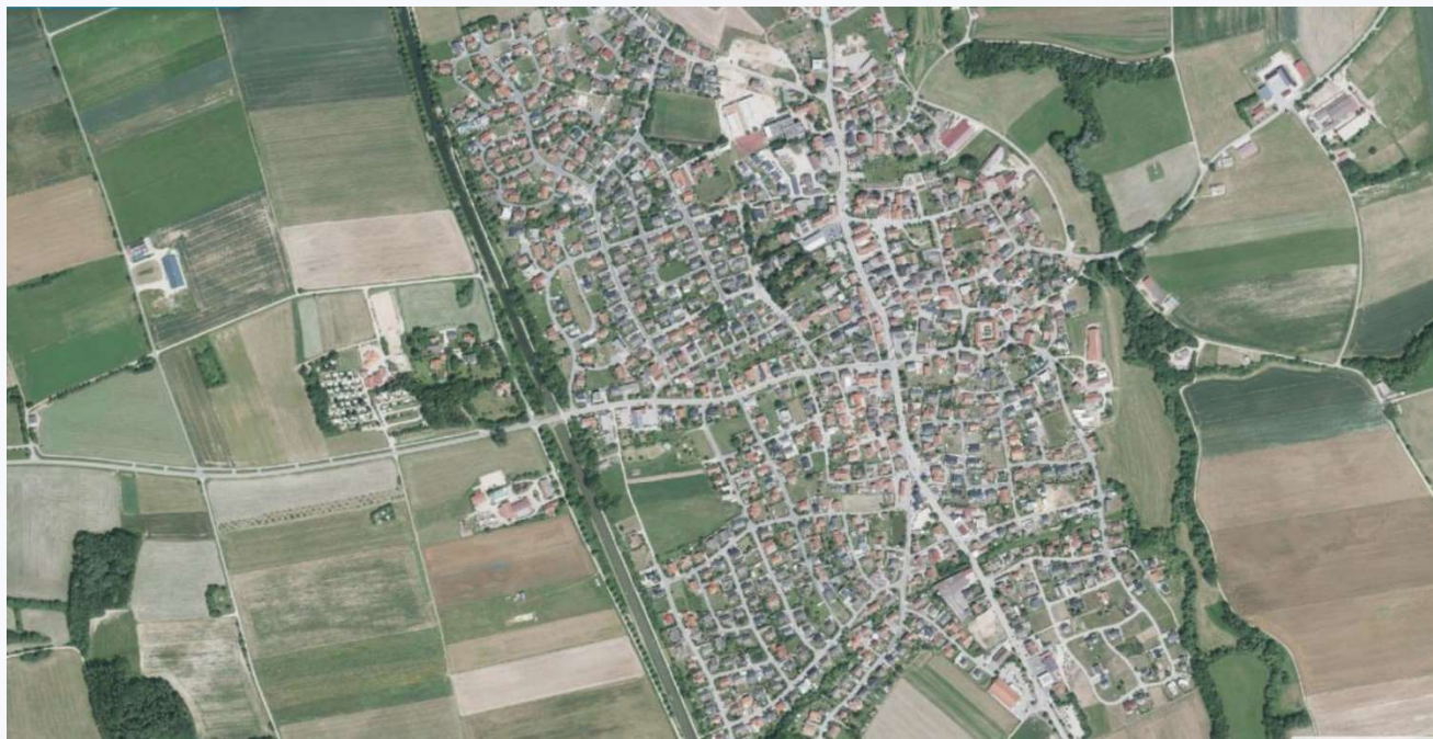
Eine von Einfamilienhäusern geprägte Siedlung
